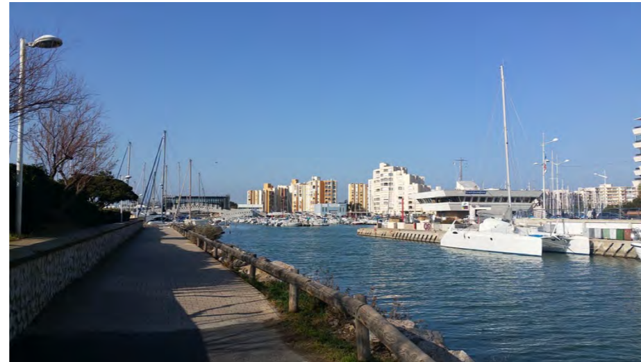
Chenal d'entrée du port, Carnon Ouest.
