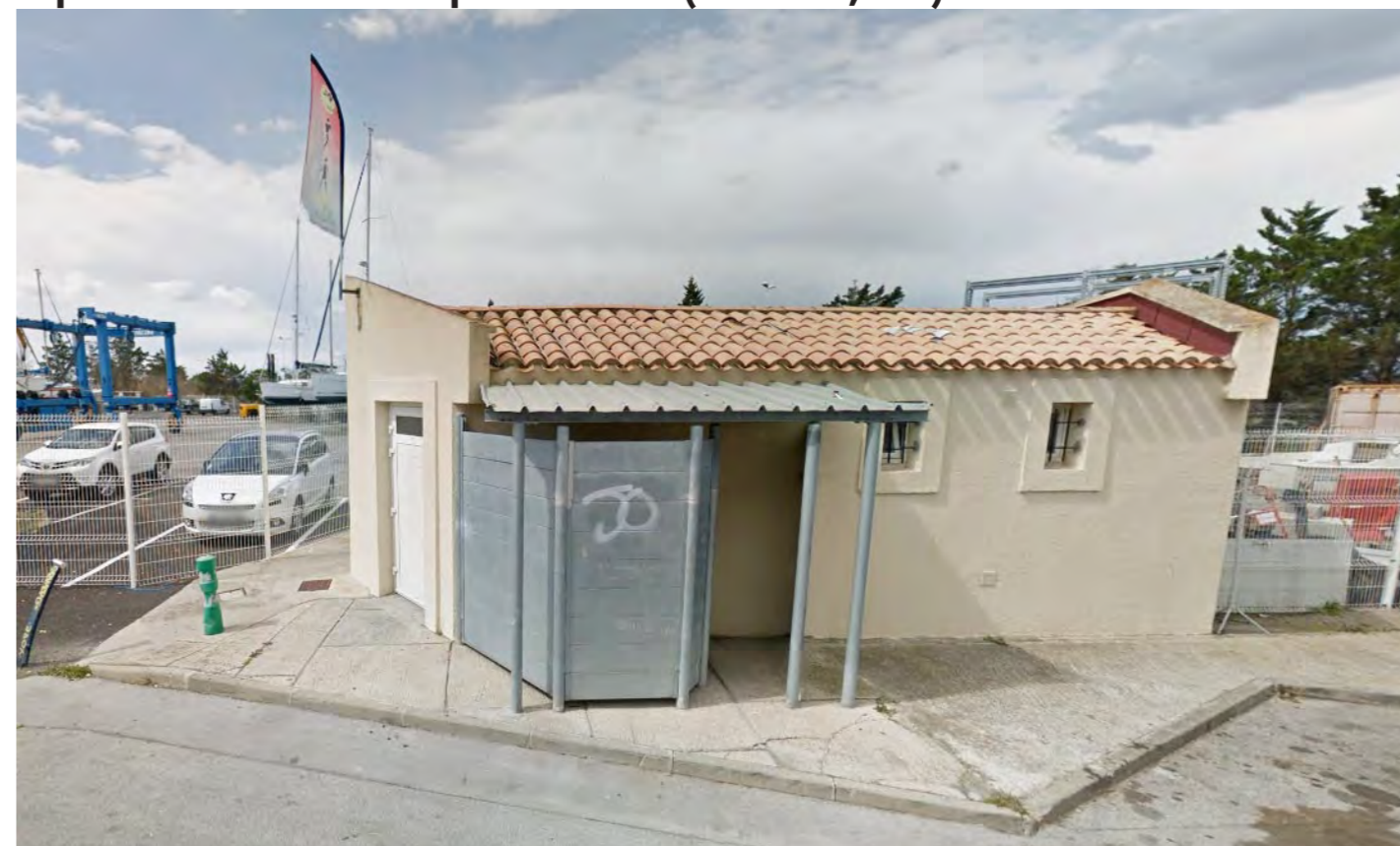
Espace de services aux plaisanciers (douches, WC)
