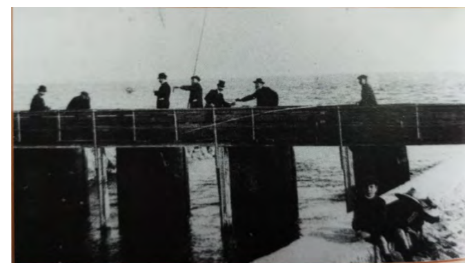
Source : « Raconte-moi Carnon » Léopoldine Dufour, le barrage à poutrelle au début du XXe siècle
