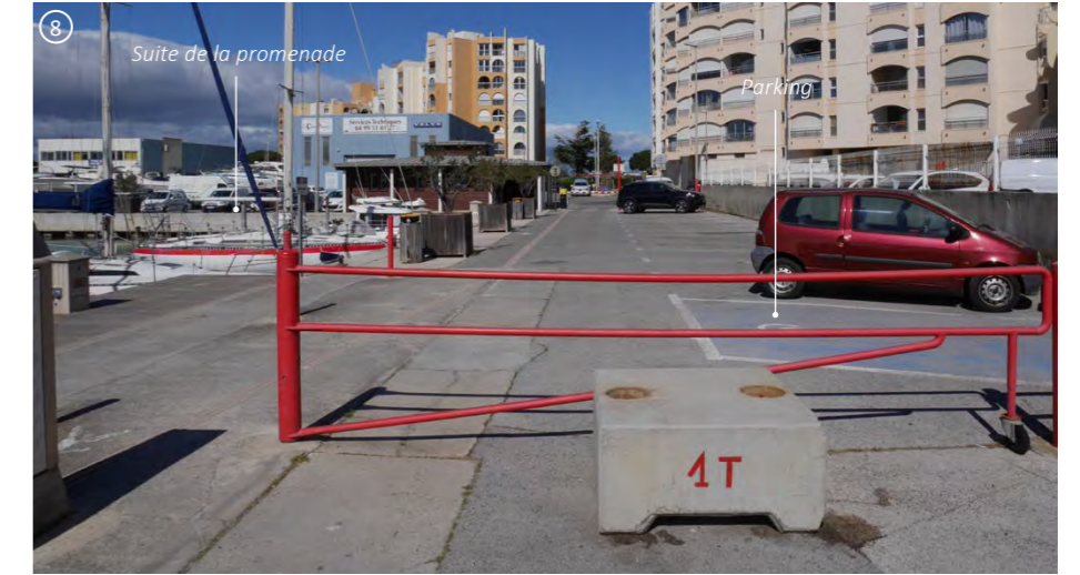
La promenade du tour du port côté Est est interrompue par un parking et la zone technique
