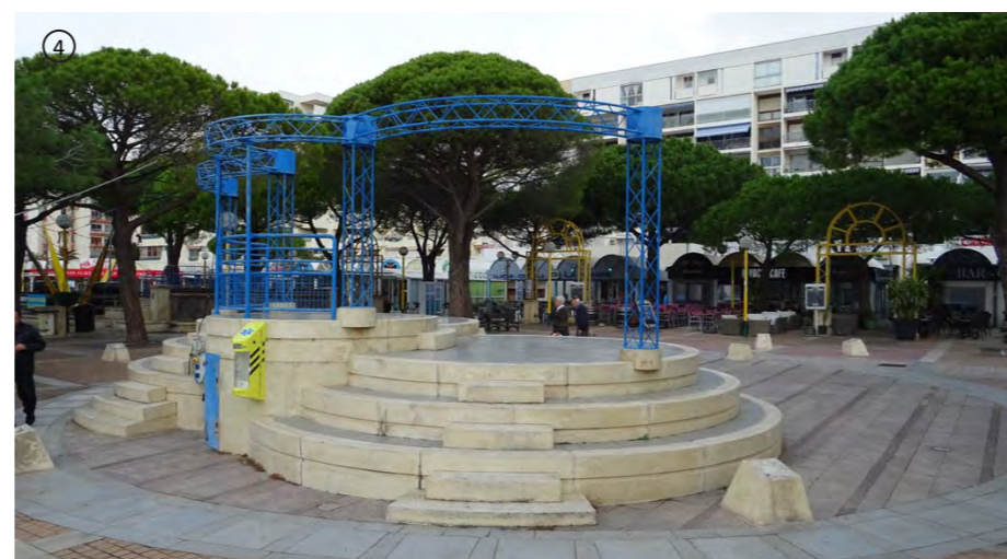
Cette estrade, située sur la place St-Marc, encombre l'espace public par son architecture imposante. Infrastructure peu utilisée hors période estivale.
